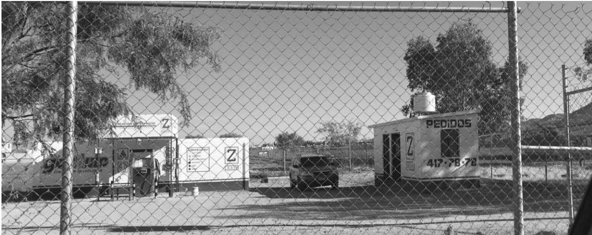
Gasera localizada a 90 metros del predio que no cuenta con el uso de suelo adecuado para el éste giro, cuenta con H45.
