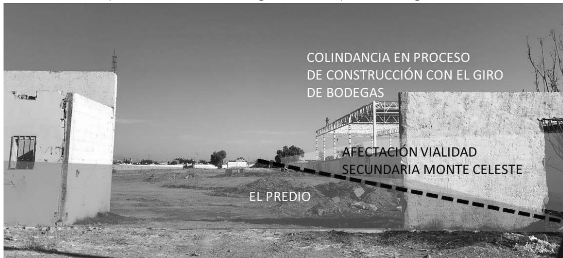
El predio y su colindancia en proceso de construcción.
