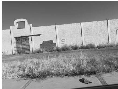
VISTA DE LA PARTE CENTRAL (BARDA EN PROCESO DE DERRIBO)
