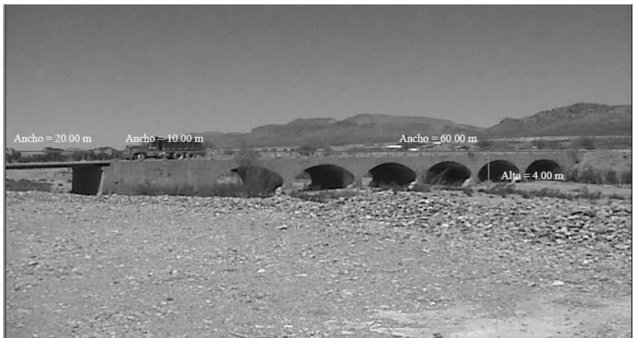
Vista del puente localizados el noreste del predio.
