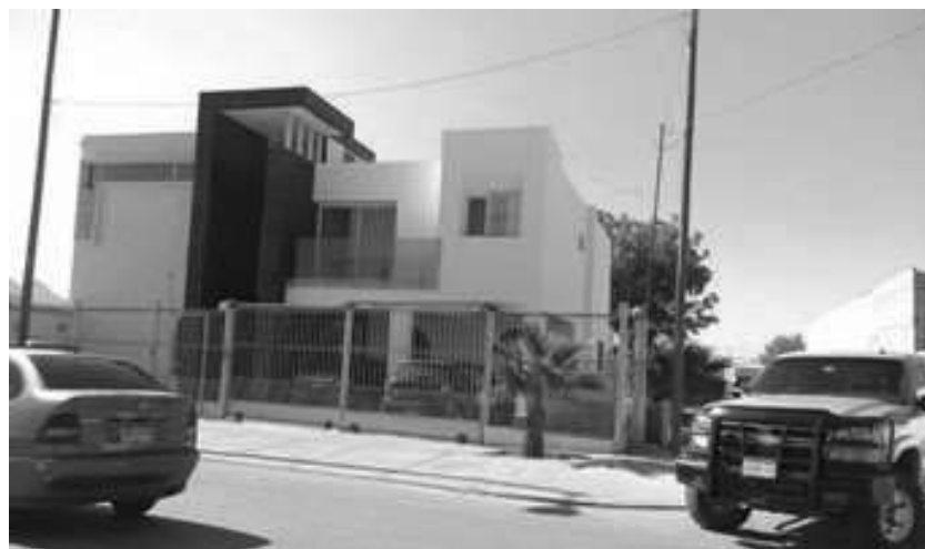
Vivienda remodelada inmersa en las colonias.
