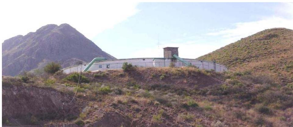
Ilustración 27: Tanque superficial de 5,000 m<sup>3</sup> de capacidad, alimentado por un alinea de 36"
