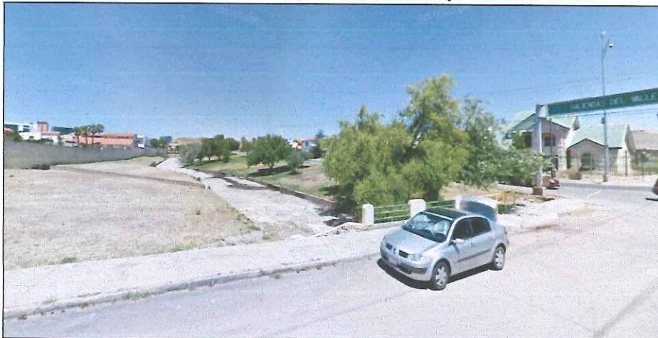
Imagen 52. Escurrimientos pluviales en el arroyo Plaza de toros.
