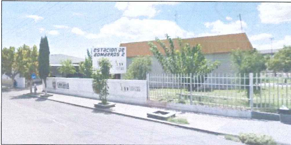
Imagen 55. Unidad de atención de emergencia, Estación de Bomberos 2.
