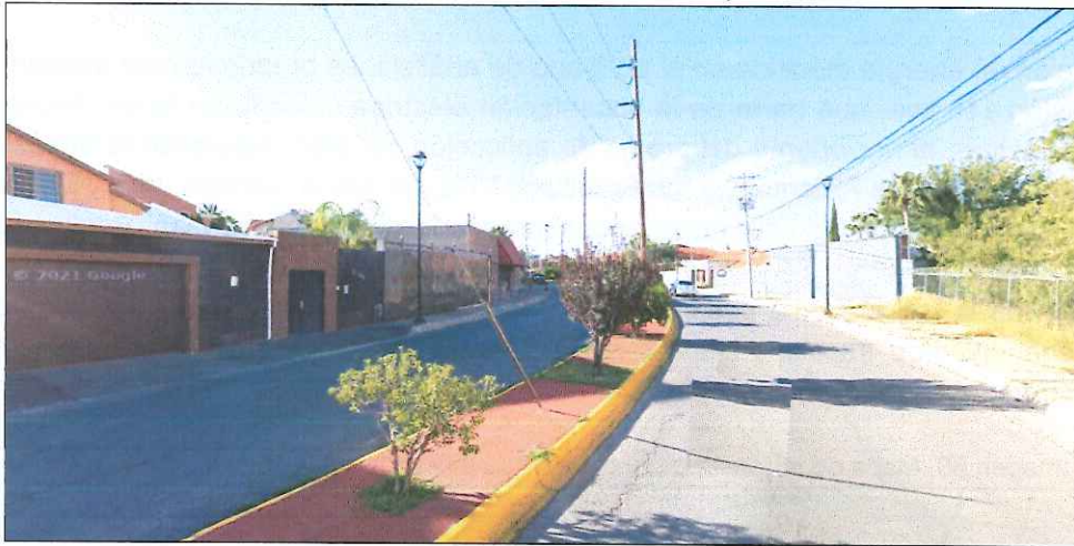
Imagen 51. Vista de red eléctrica en av. Enrique Elfas Muller.
