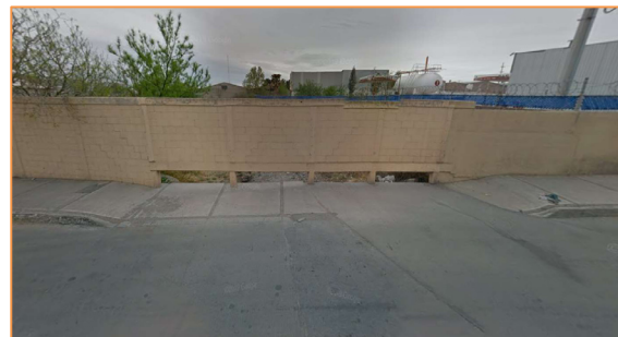
Imagen 24. Infraestructura pluvial existente de paso a desnivel vehicular Arroyo El Saucito. Fuente. Fotografía Propia.
