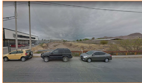
Imagen 23. Infraestructura pluvial existente de paso a desnivel vehicular Arroyo El Mimbres. Fuente. Fotografía Propia.
