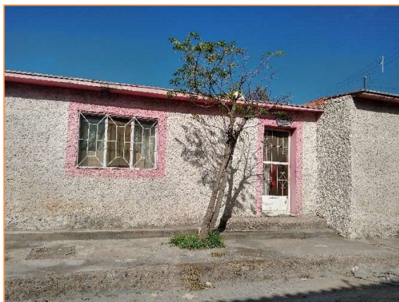
Imagen 4. Vivienda Unifamiliar en Colonia San Vicente de Nombre de Dios, dentro del área de estudio, Calle General Rosalio Hernández. Fotografía Propia.
