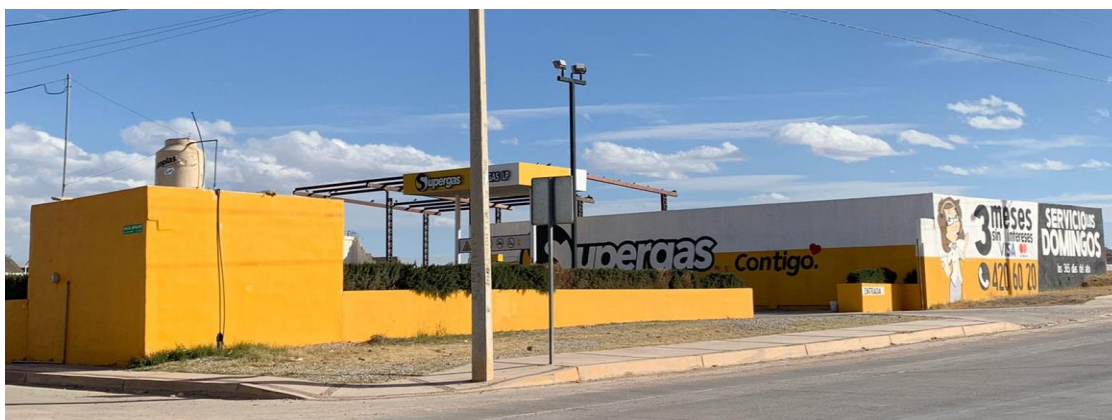
Imagen 42. Estación de servicio de venta de gas L.P ubicada en Av. Neandertal y calle Antílope
