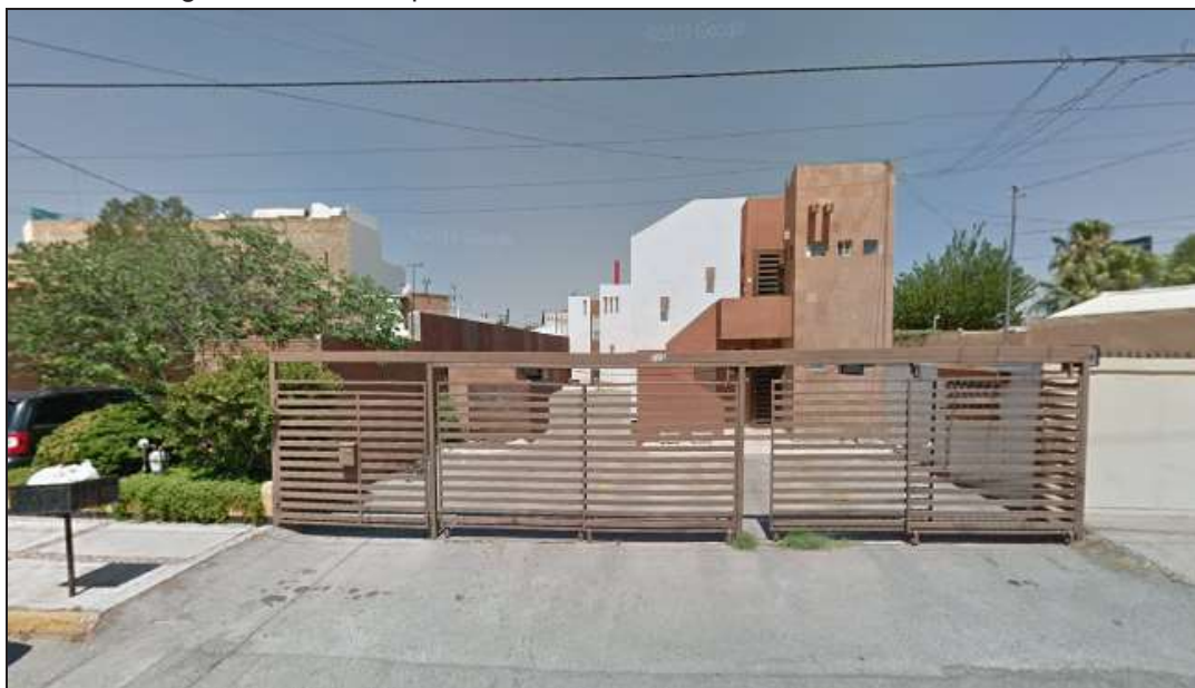
Imagen 73. Vista del predio de estudio, calle Francisco Briones No. 213.
