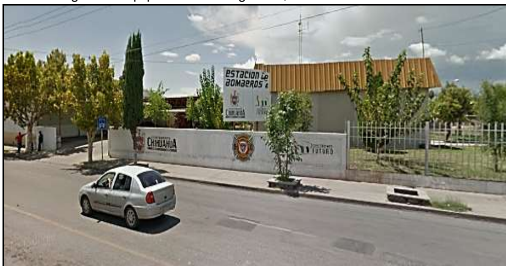
Imagen 29. Equipamiento de seguridad, Estación de Bomberos No. 2.
