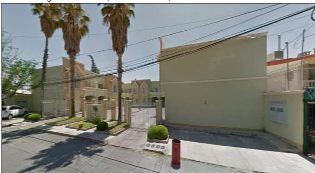
Imagen 69. Vista del predio de estudio, calle Francisco Briones No. 212.
