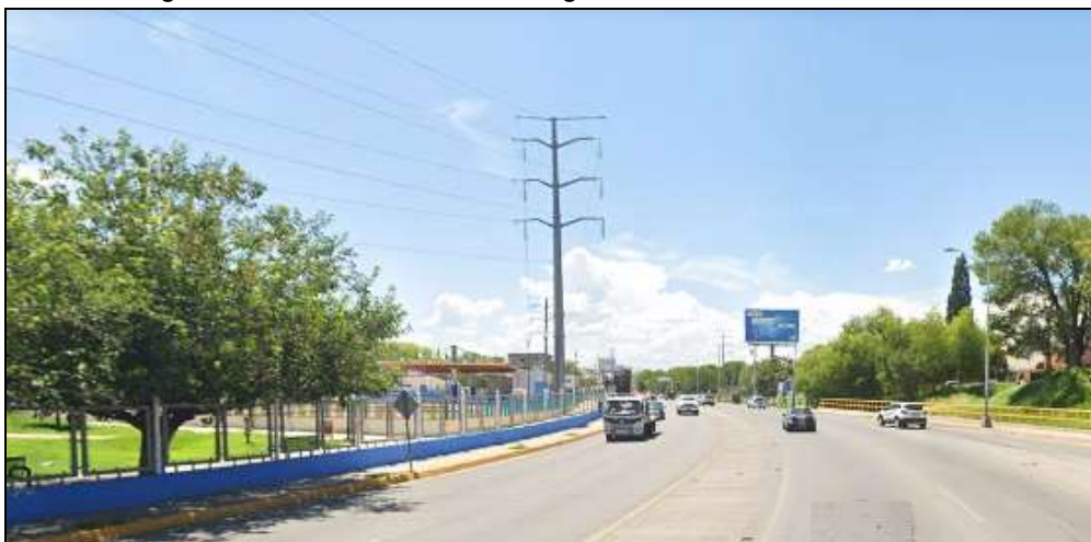
Imagen 45. Infraestructura de energía eléctrica en av. De la cantera.
