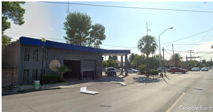
Ubicación de la Estación No. 4 del H. Cuerpo de Bomberos Fuente: Google Earth Pro. Image©2022 Maxar Technologies.
