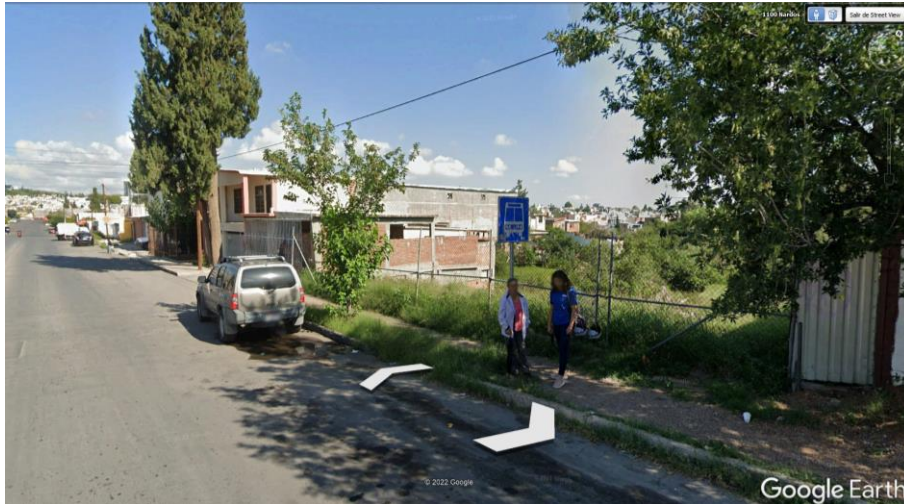
Arroyo El Barro en la calle 38 casi esquina con calle 14 de julio / Violetas Fuente: Google Earth Pro. Image©2022 Maxar Technologies
