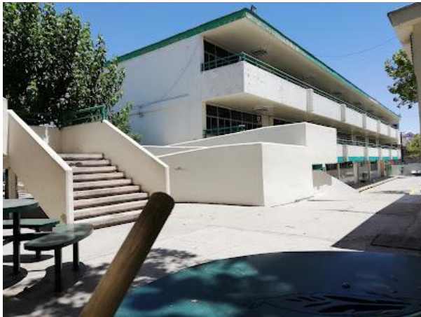
Foto 5. Colegio de Bachilleres Plantel 2 a 641.94 m.
