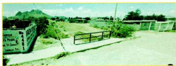
Imagen 2. Cruce de Arroyo Los Nogales, entre Calle Sicomoros y 31 a . Fotografía Propia.
