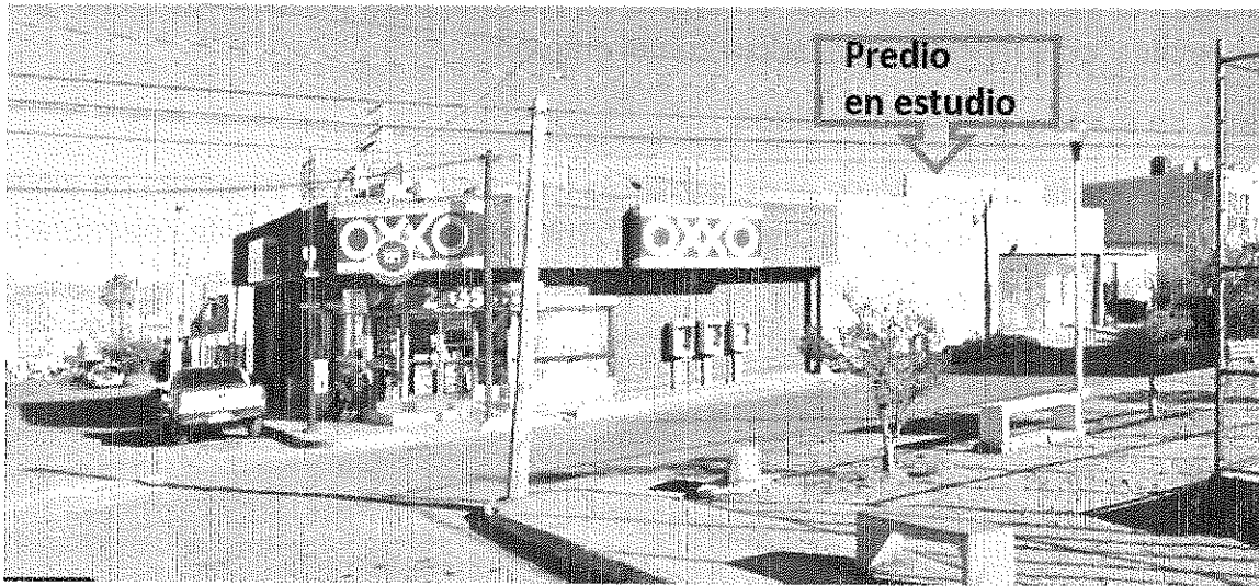
Vista del inmueble en estudio (bodega). Fuente propia TDU2023
