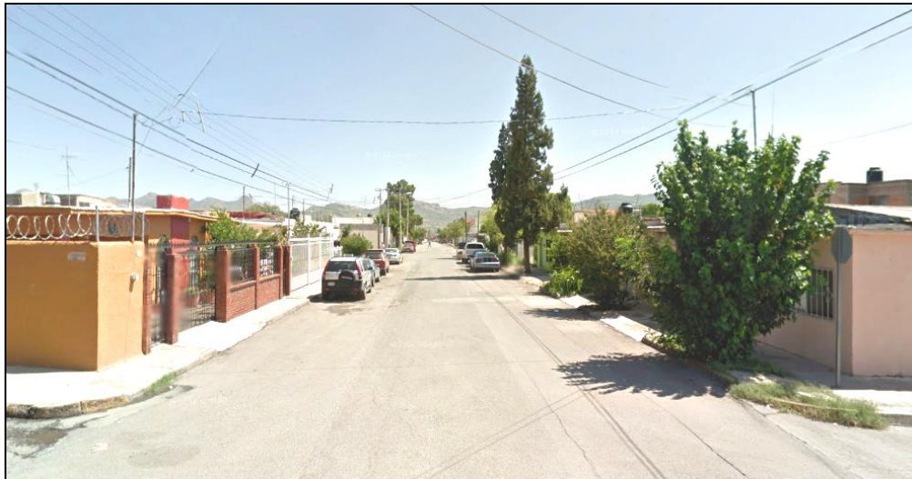
Imagen 95. Vista de infraestructura cercana al predio de aplicación del plan.
