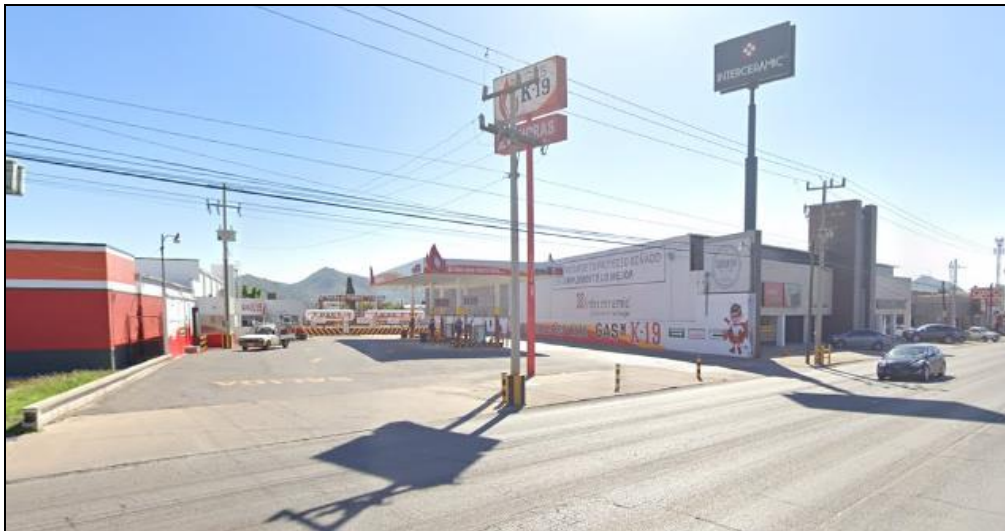
Imagen 68. Riesgo antropogénico, Gas “K-19”, en Av. Tecnológico.
