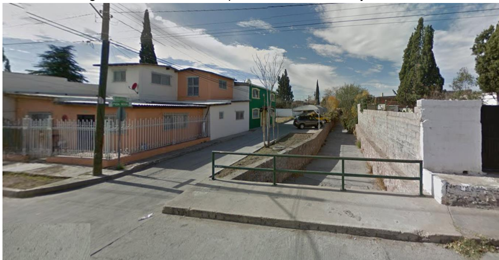
Imagen 65. Escurrimientos pluviales, hacia el arroyo La Galera.
