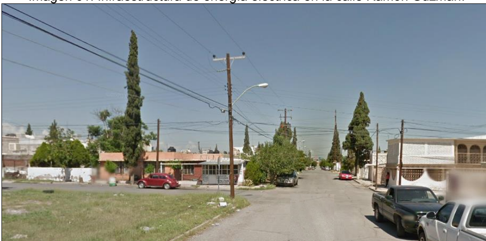
Imagen 61. Infraestructura de energía eléctrica en la calle Ramón Guzmán.
