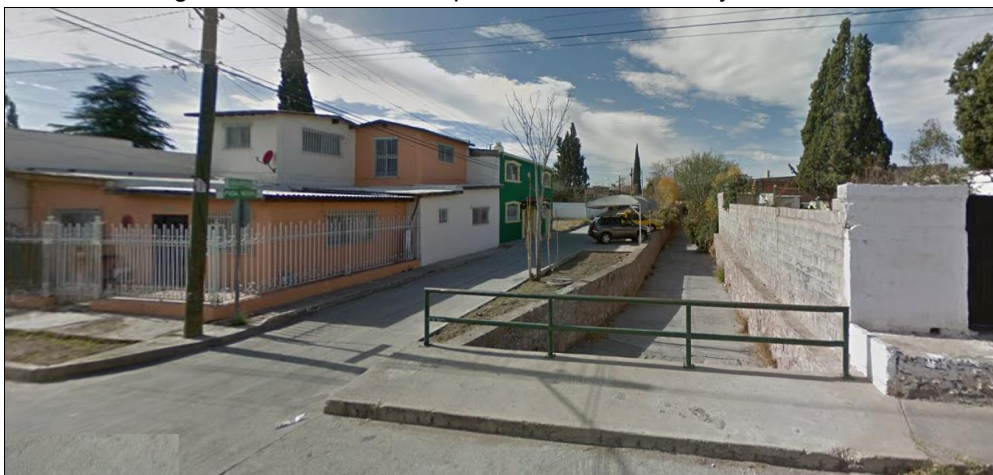
Imagen 57. Escurrimientos pluviales, hacia el arroyo La Galera.
