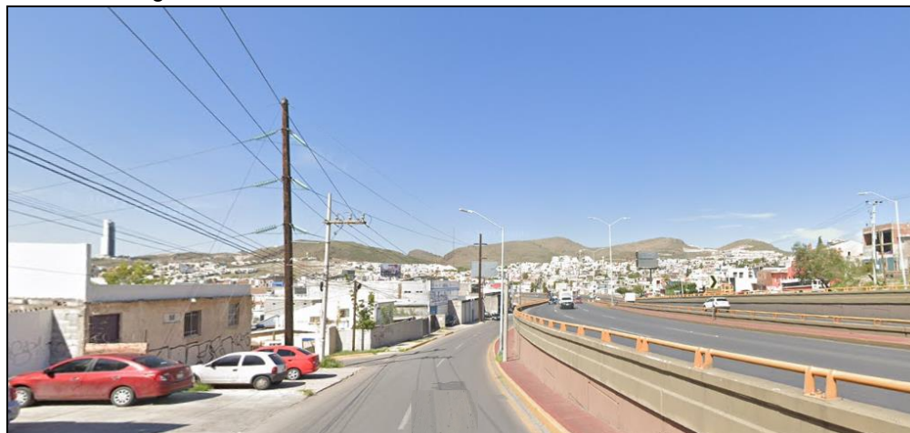
Imagen 47. Red eléctrica de 115 Kva, en el Perif. De la Juventud.
