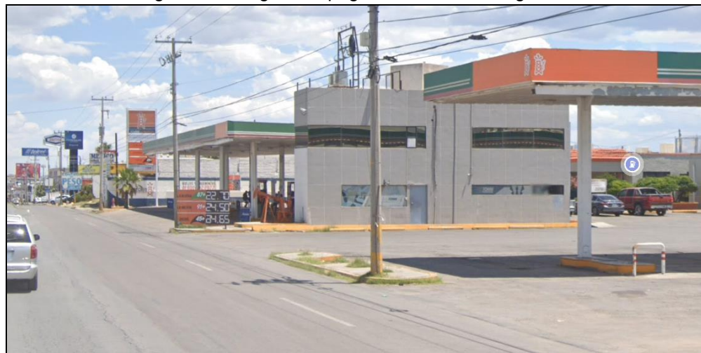
Imagen 53. Riesgo antropogénico, estación de gasolina.
