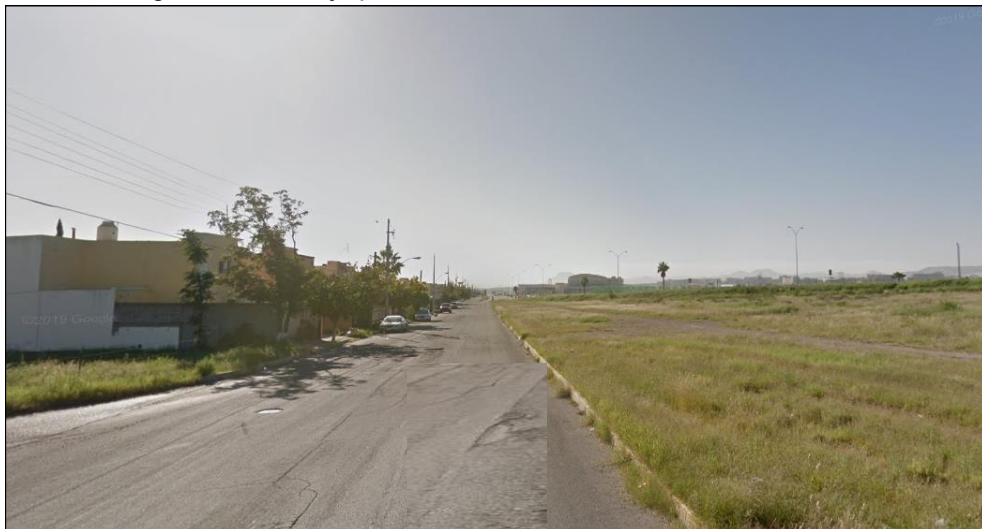
Imagen 45. Desalojo pluvial sobre calle Paseos de la Universidad.
