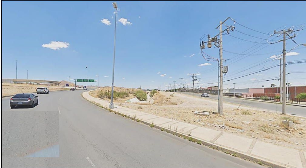
Imagen 44. Vista del arroyo El Picacho para desalojo pluvial de la zona.
