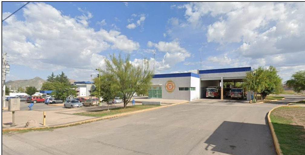
Imagen 30. Equipamiento de seguridad, Estación de Bomberos No. 3.
