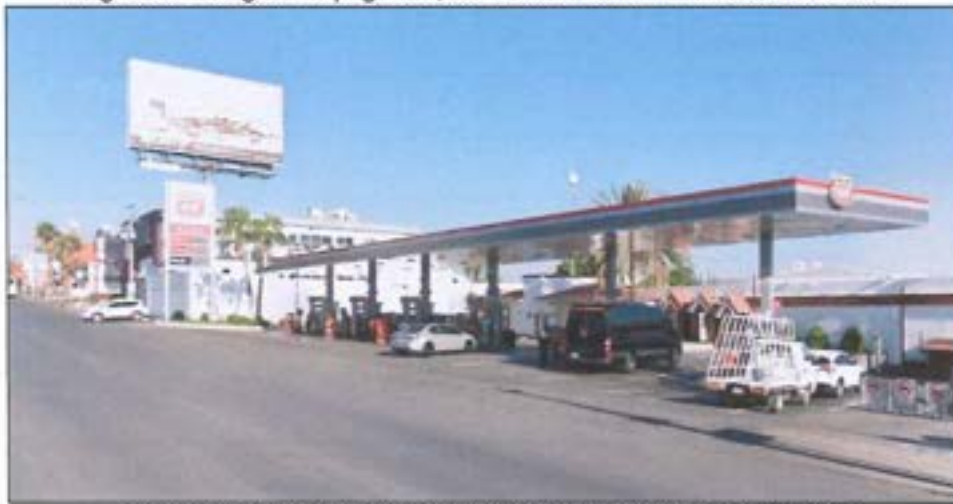
Imagen 59. Riesgo antropogénico, Gasolinera en Av I. Politécnico Nacional.
