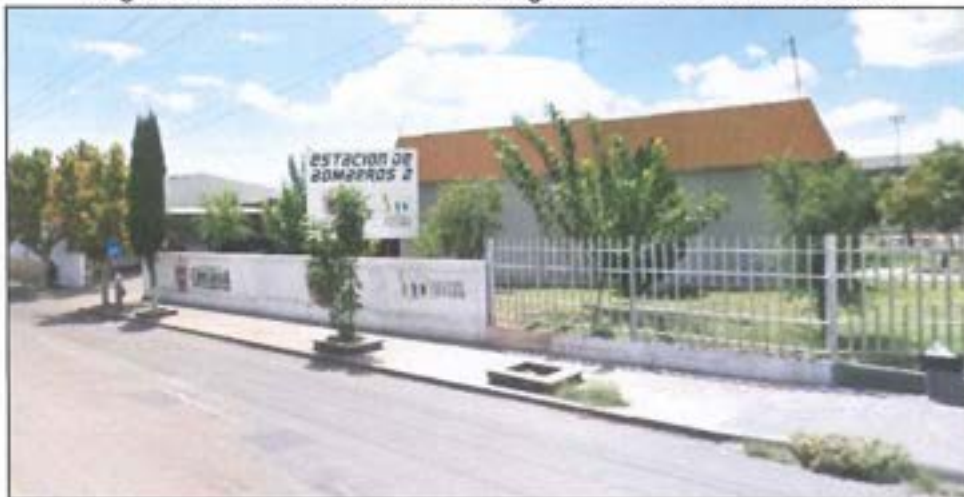
Imagen 60. Unidad de atención de emergencia. Estación de Bomberos 2.
