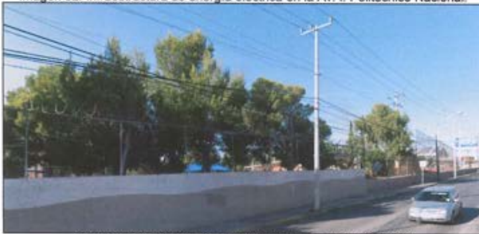
Imagen 52. Infraestructura de energía eléctrica en la Av. I. Politécnico Nacional.
