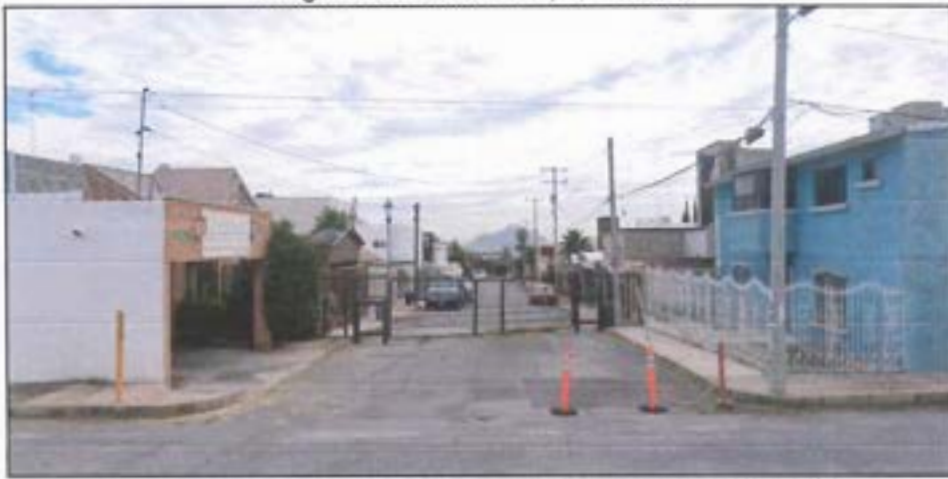
Imagen 45. Vialidad local, C. La Salle.
