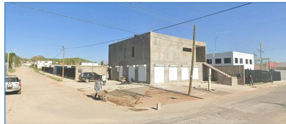
Imagen 6. BODEGAS Y OFICINAS. Fotografía Google Earth.
