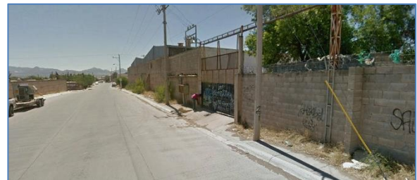
Imagen 3. BODEGAS Y TALLERES VARIOS. Fotografía Google Earth
