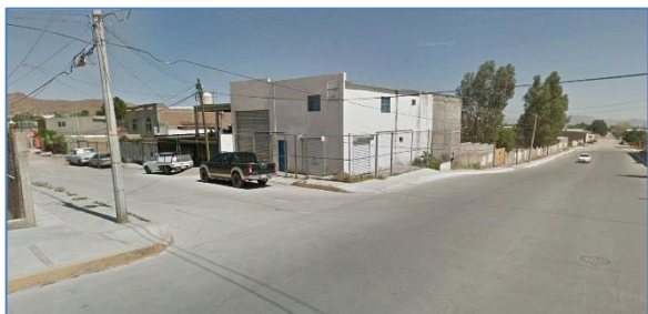
Imagen 13. Bodegas y OFICINAS. Fotografía Google Earth
