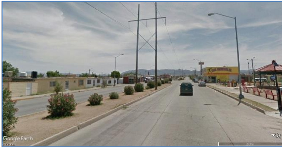
Imagen 35. Líneas de alta tensión eléctrica ubicadas en la Calle 15ª. Fuente; Google earth.
