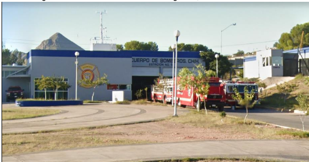
Imagen 60. Unidad de atención de emergencia, Estación de Bomberos.
