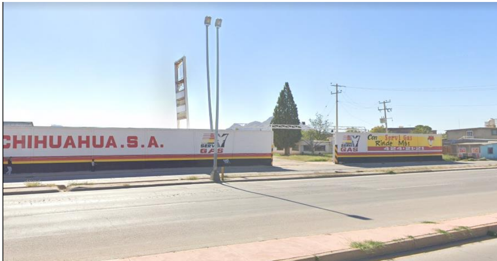
Imagen 59. Riesgo antropogénico, Gasera.
