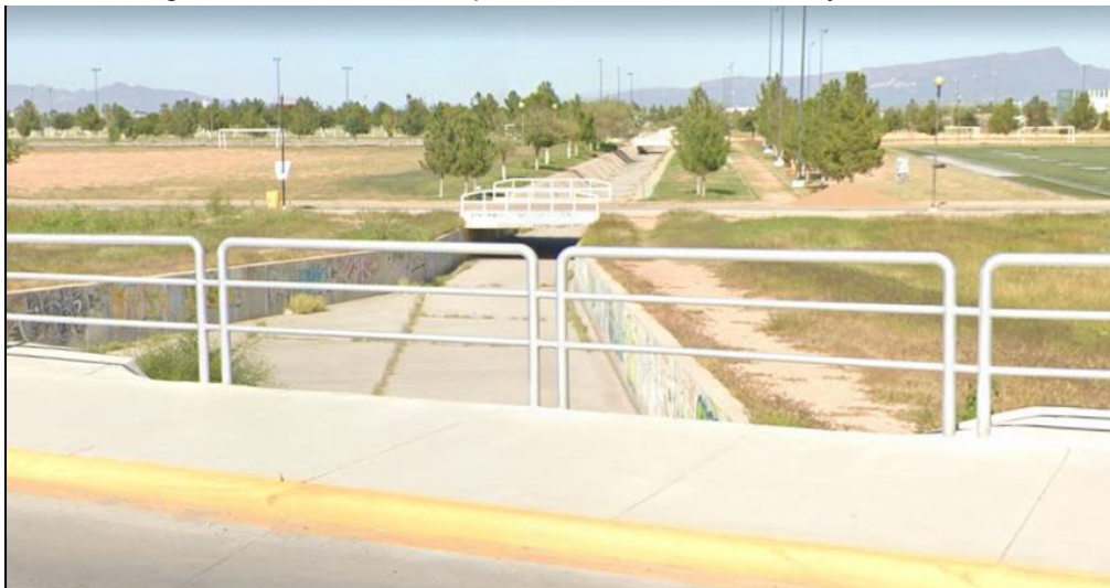
Imagen 55. Escurrimientos pluviales con rumbo al arroyo Concordia.
