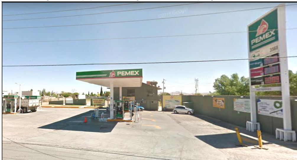
Imagen 38. Equipamiento de gasolineras en el polígono de análisis.
