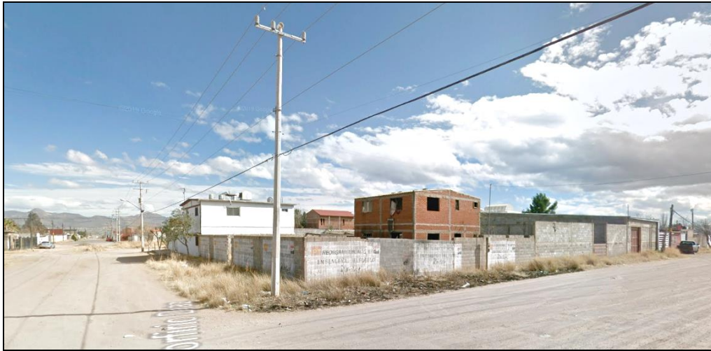
Imagen 54. Vista de redes eléctricas frente al predio de estudio.
