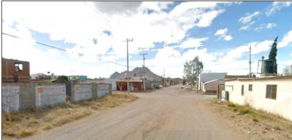
Imagen 48. Estructura vial en la zona, calle 19a.
