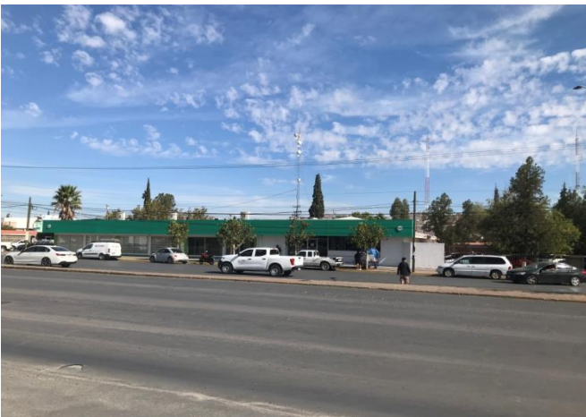
Fig. 69 Agencia CFE y subestación eléctrica Tecnológico. 79
