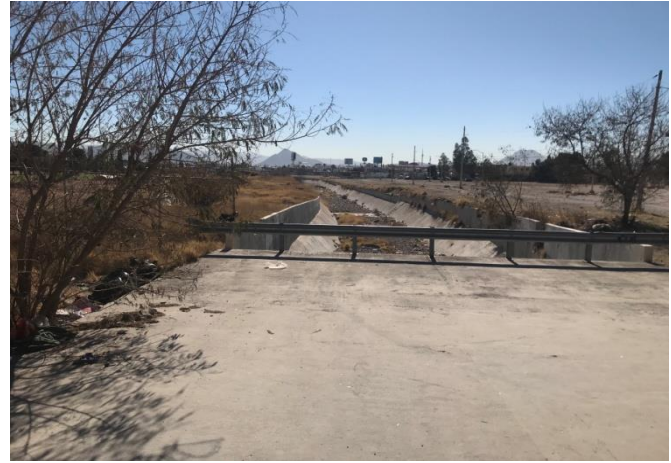
Fig. 71 Canalización en arroyo El Mimbres. 81
