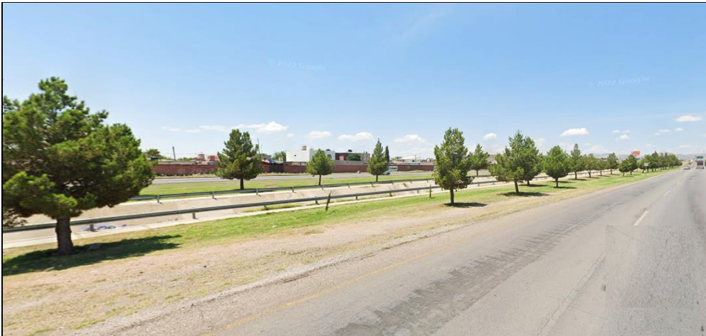
Imagen 41. Vista del arroyo Nogales norte para desalojo pluvial de la zona.
