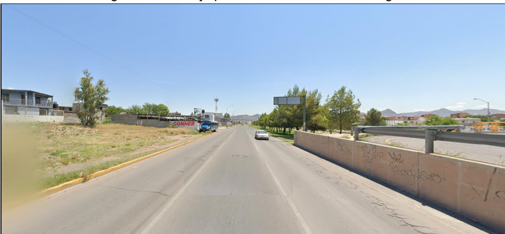
Imagen 42. Desalojo pluvial sobre Vialidad Los Nogales.
