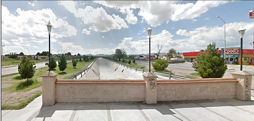
Imagen 46. Infraestructura pluvial, canalización del Arroyo Nogales norte.
