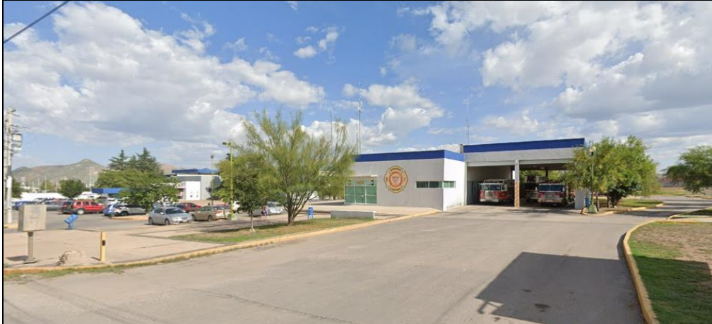
Imagen 29. Equipamiento de seguridad, Estación de Bomberos No. 3.
