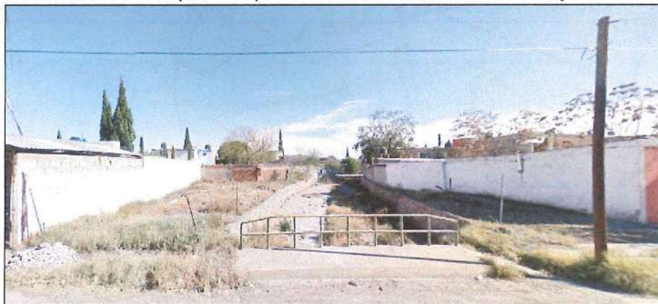
Imagen 57. Esgurrimientos pluviales por calle Priv José María Mata al arroyo La Galerera sur.
