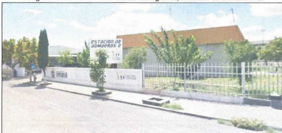
Imagen 64. Unidad de atención de emergencia, Estación de Bomberos 2.
