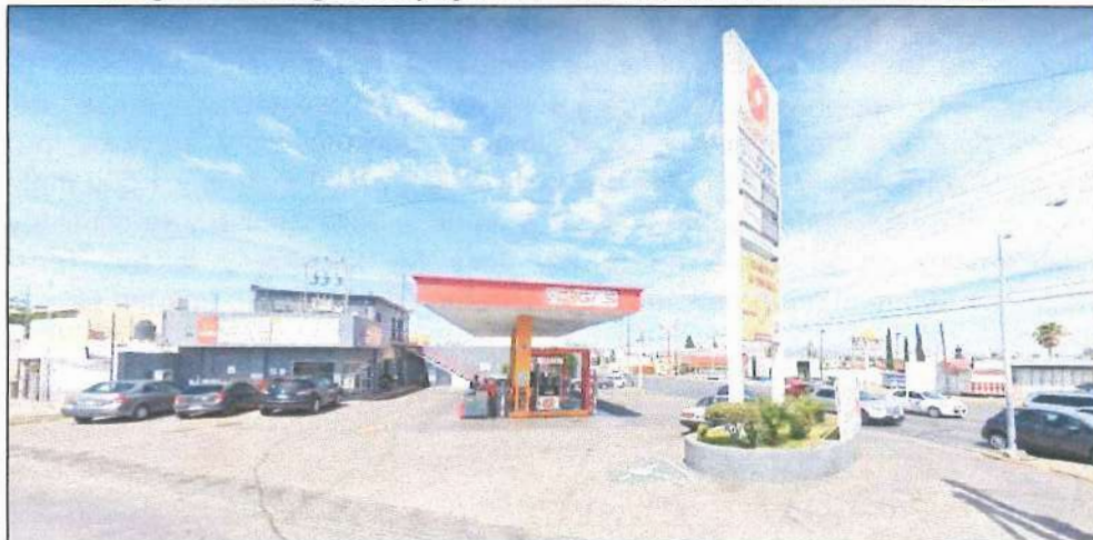
Imagen 63. Riesgo antropogénico, Gasolinera, en av. De las Américas.
