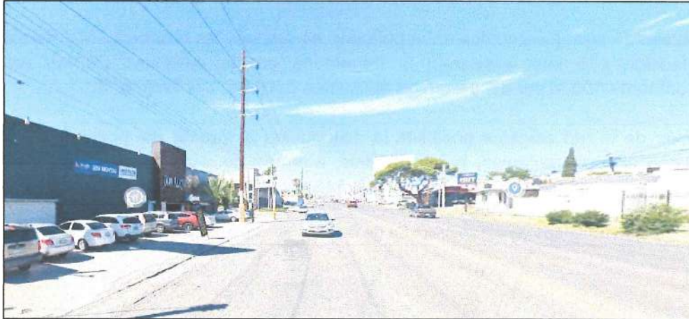
Imagen 54. Vista de red eléctrica en av. De las Américas.
