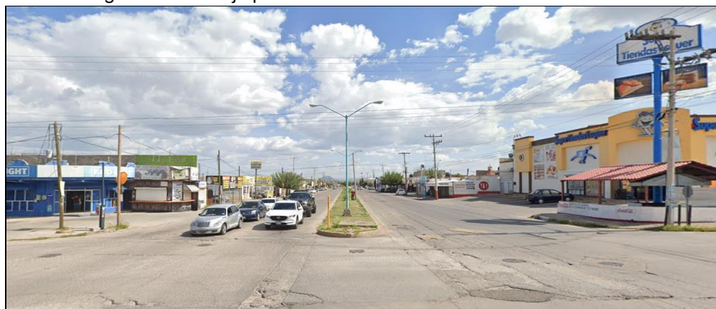
Imagen 42. Desalojo pluvial sobre Vialidad Hidroeléctrica Chicoasén.
