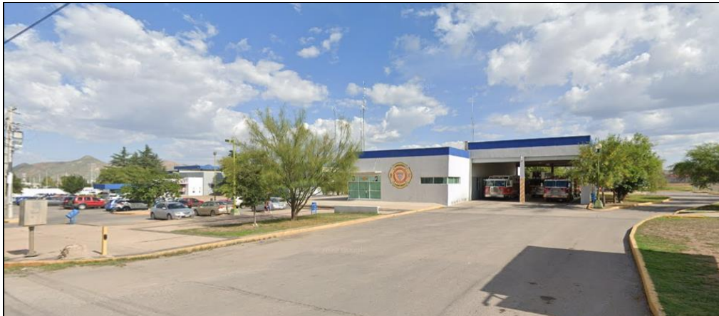
Imagen 29. Equipamiento de seguridad, Estación de Bomberos No. 3.
