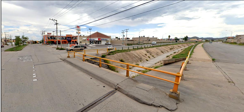
Imagen 46. Infraestructura pluvial, canalización del Arroyo Los Arcos.
