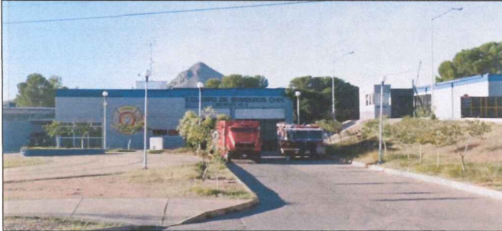
Imagen 26. Unidad de atención de emergencia, Estación de Bomberos.
