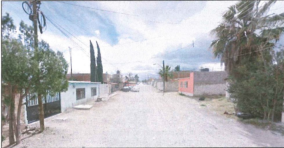
Imagen 63. Vista de infraestructura eléctrica cercana al predio de estudio.
