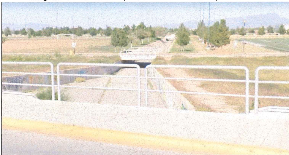
Imagen 55. Escurrimientos pluviales con rumbo al arroyo Concordia.
