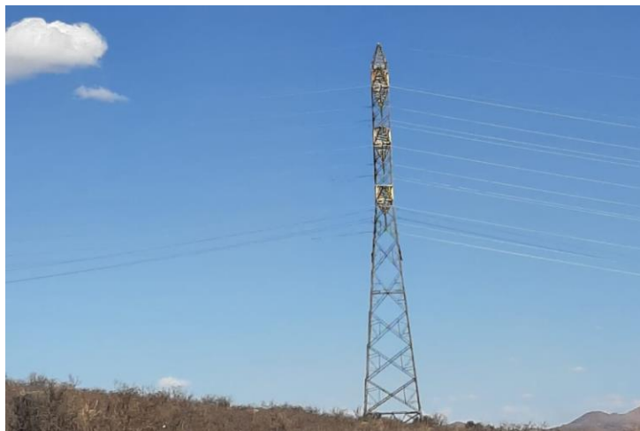
IMAGEN 83.- Líneas de alta tensión en el área de estudio. Fuente: elaboración propia.
