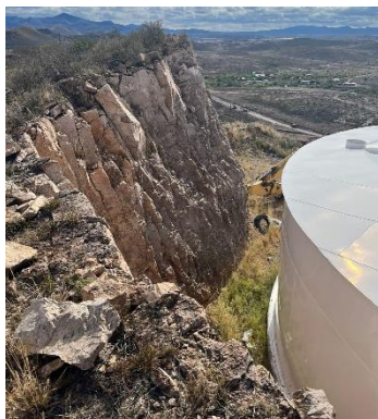
IMAGEN 78.- Tanque de JMAS. Fuente: Elaboración propia.
