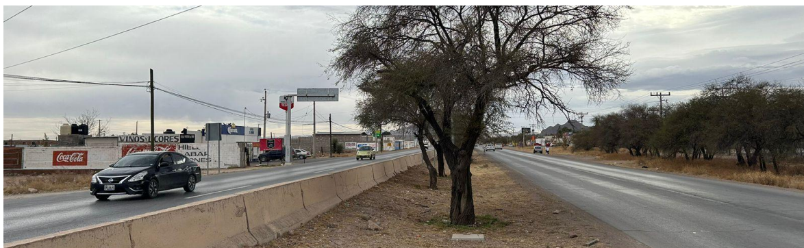
Ilustración 133. Ejemplo de vialidad regional, carretera Chihuahua-Ojinaga
