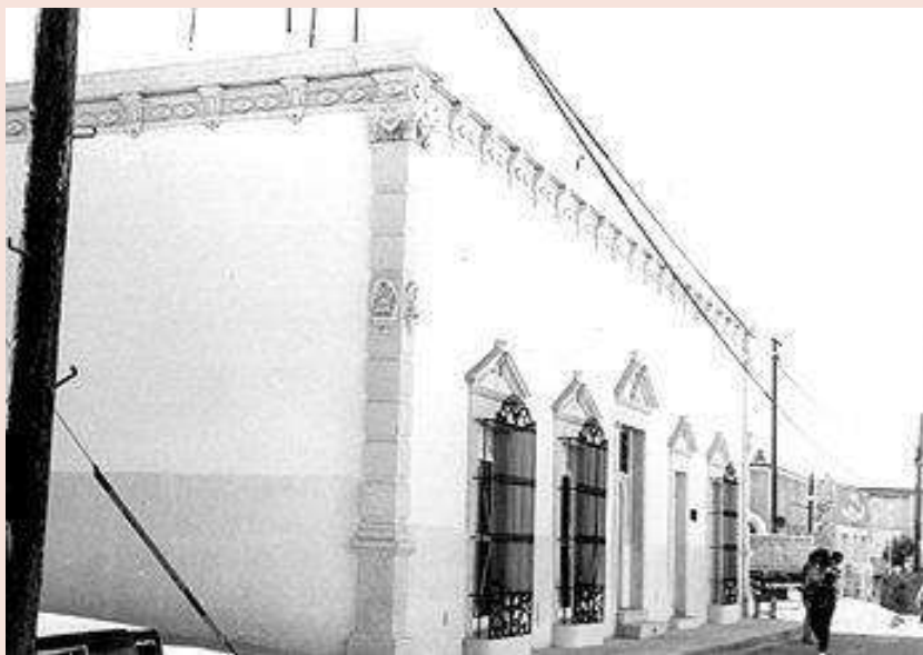
Fotografía Del inmueble de casa habitación catalogado. Recuperada del Catálogo INAH.
