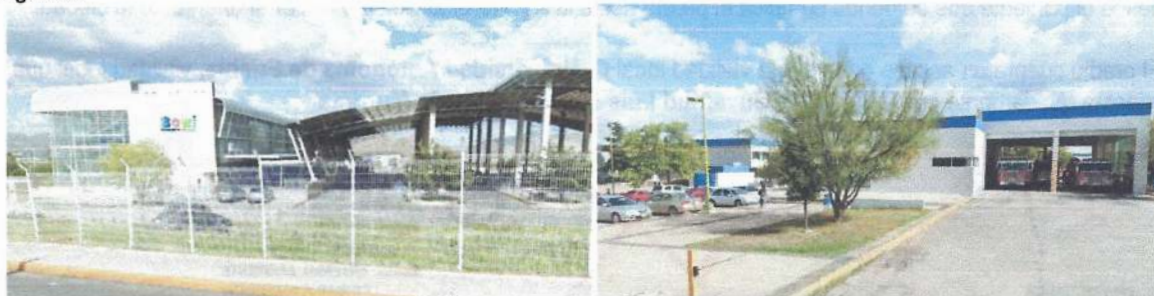
Imagen 51. Estación de Transferencia Bowi y Estación Dual de Bomberos y Policía. Fuente: Google Earth, septiembre 2024.
