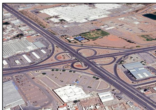
Distribuidor vial Avenida Homero-Tecnológico
