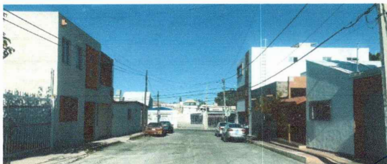
Imagen 37. Calle Privada de Las Américas, sección vial de 12.00 metros
