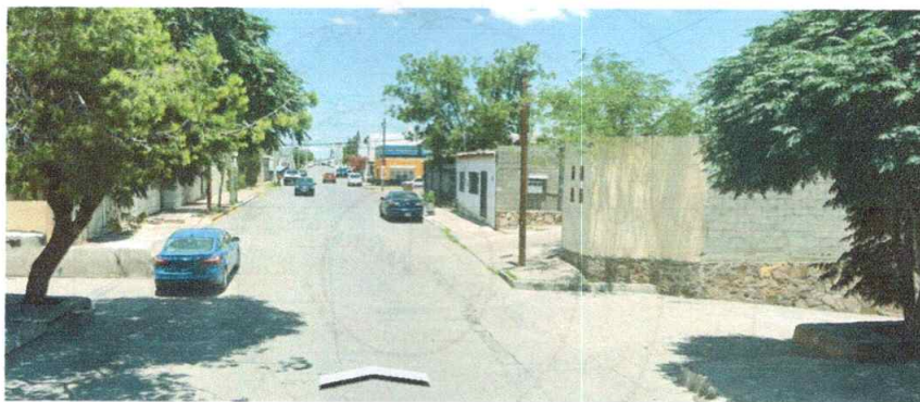
Imagen 45. Punto de riesgo de inundación, intersección de la calle José Martí con arroyo La Galera Sur
