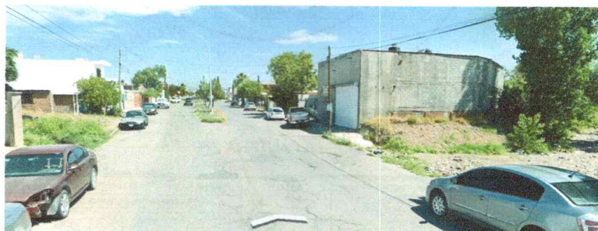
Imagen 46. Punto de riesgo de inundación, intersección de la calle José Martí con arroyo La Galera Norte
