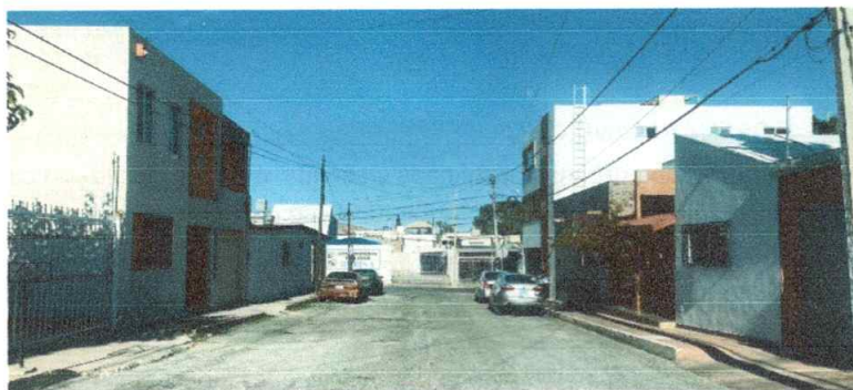
Imagen 58. Calle Privada de Las Américas, sección vial de 12.00 metros
