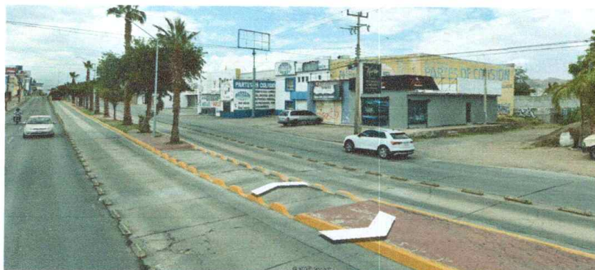
Imagen 47. Punto de riesgo de inundación, intersección de la Av. Vallarta con arroyo La Galera Norte y Sur
