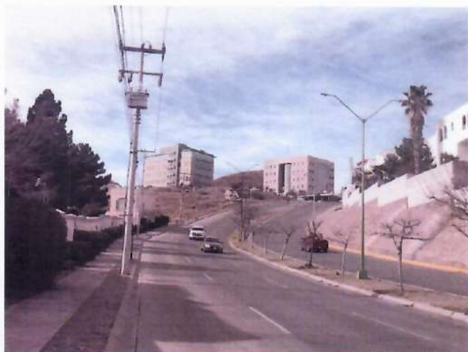
Fig. 18 Vista del conjunto Punto Alto desde corredor Av. Valle Escondido. 28
