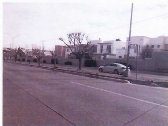
Fig. 66 Canal pluvial en Av. Valle Escondido. 76
