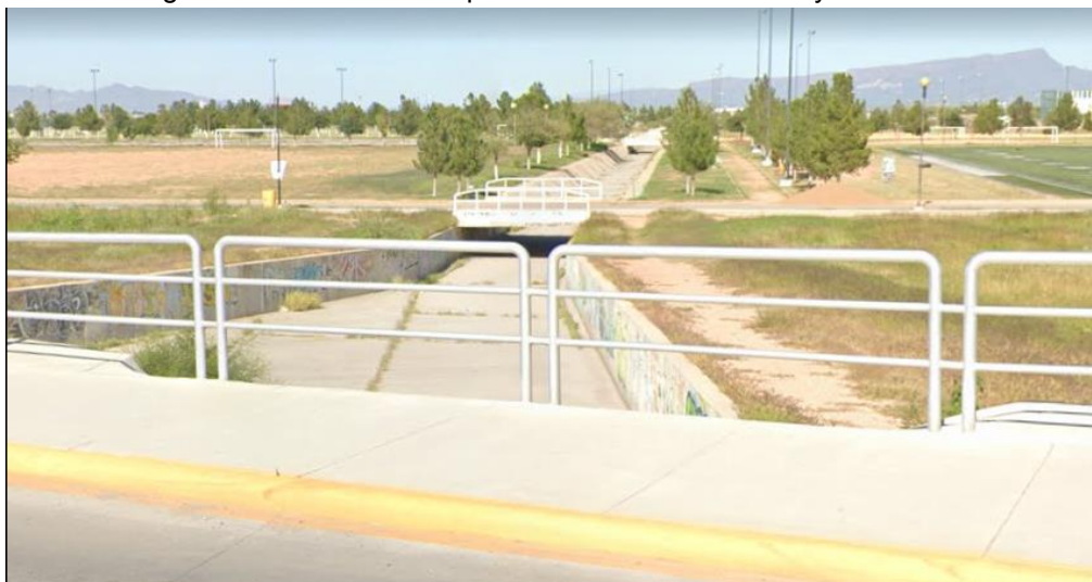
Imagen 55. Escurrimientos pluviales con rumbo al arroyo Concordia.
