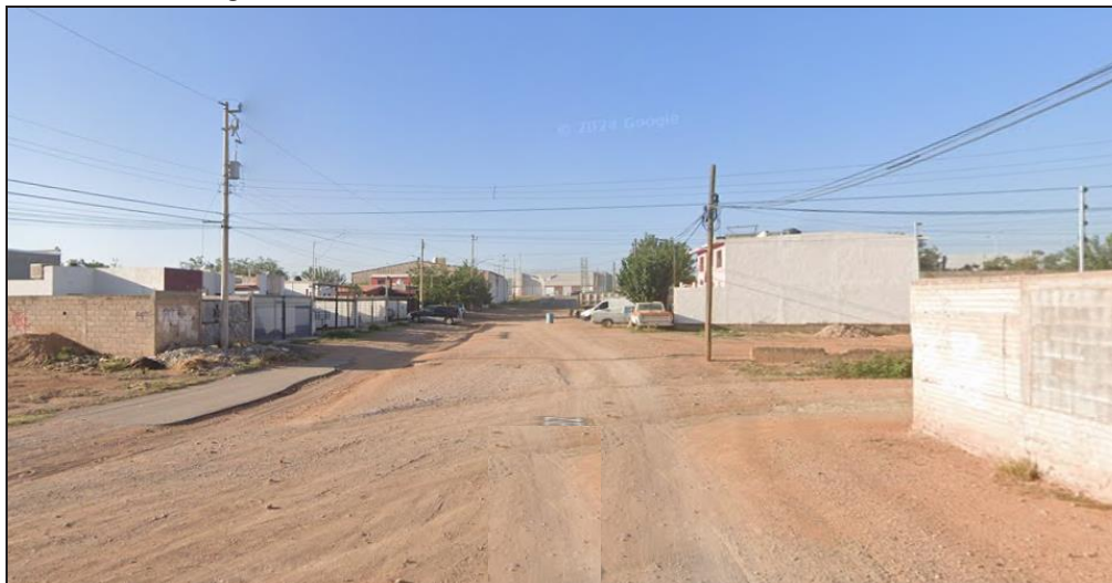
Imagen 46. Estructura vial en la zona, C. Porfirio Díaz Mori.
