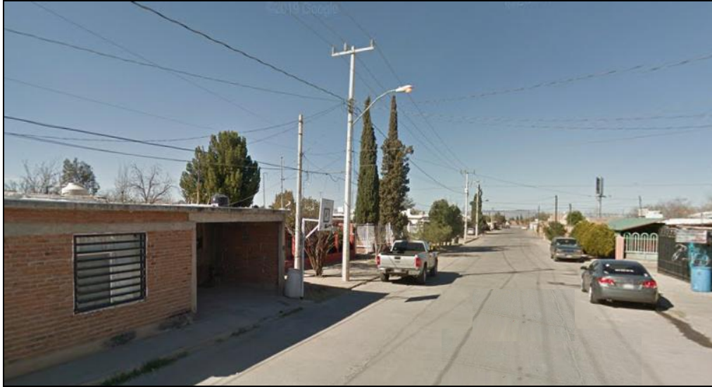
Imagen 60. Vista de infraestructura eléctrica cercana al predio de estudio.
