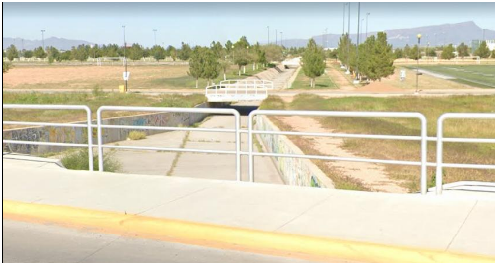
Imagen 52. Escurrimientos pluviales con rumbo al arroyo Concordia.
