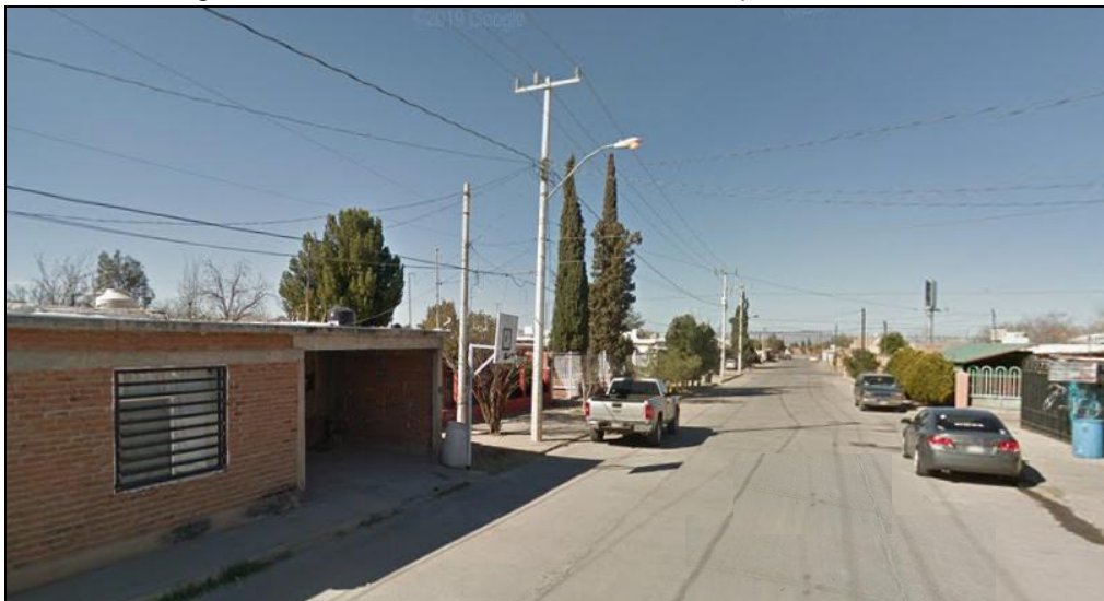
Imagen 51. Vista de redes eléctricas frente al predio de estudio.
