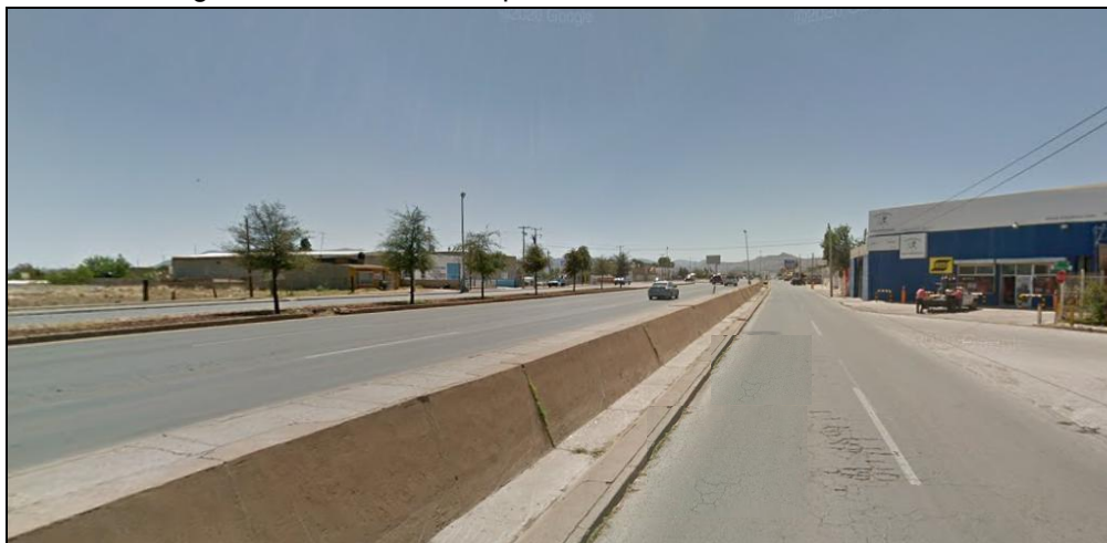
Imagen 11. Vistas del dren pluvial en Blvd. José Fuentes Mares.
