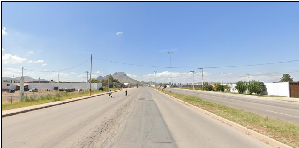
Imagen 42. Estructura vial en la zona, Blvd. José Fuentes Mares.
