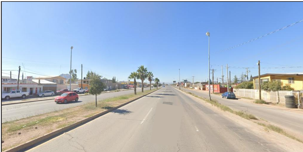
Imagen 44. Estructura vial en la zona, Blvd. José Fuentes Mares.
