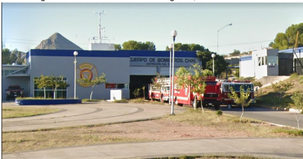
Imagen 57. Unidad de atención de emergencia, Estación de Bomberos.
