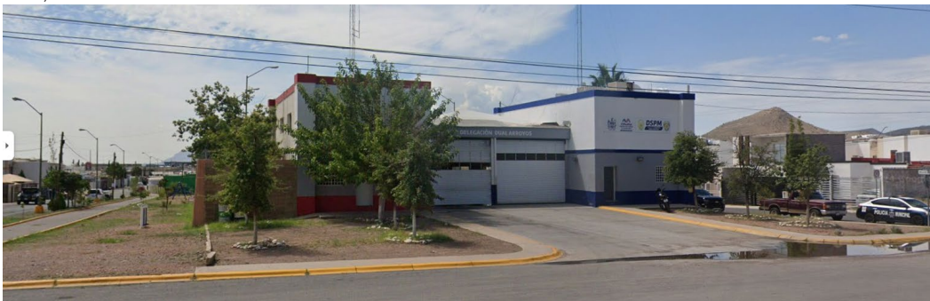
Imagen 61. Estación de Bomberos No. 6. Fuente: Captura del Google Earth 2025.
