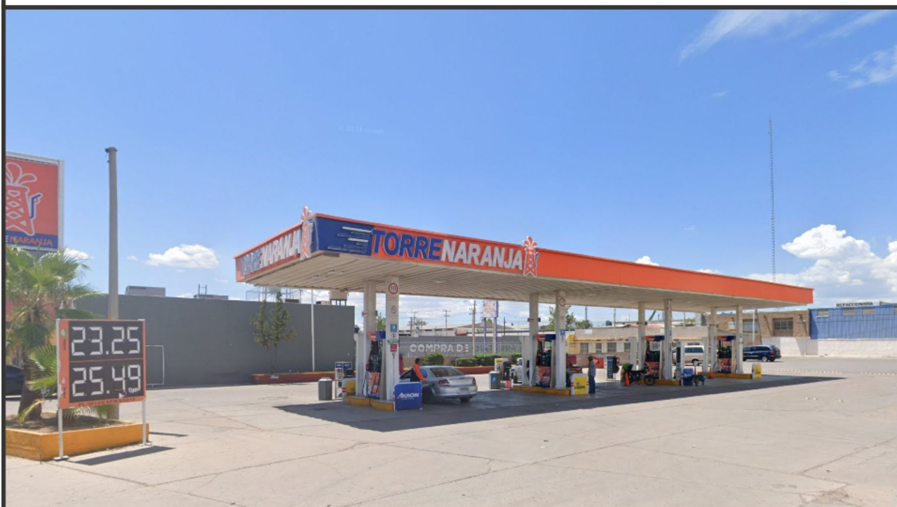
IMAGEN 58.- ELEMENTO DE RIESGO QUÍMICO - TECNOLÓGICO
