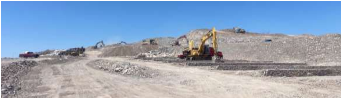
Ilustración 21. Terracerías de predio en estudio. Fuente: Propia TDU 2025.
