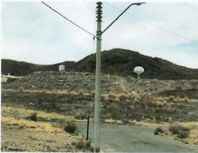
Fig. 68 Tanques de almacenamiento de agua potable Bahías. 78
