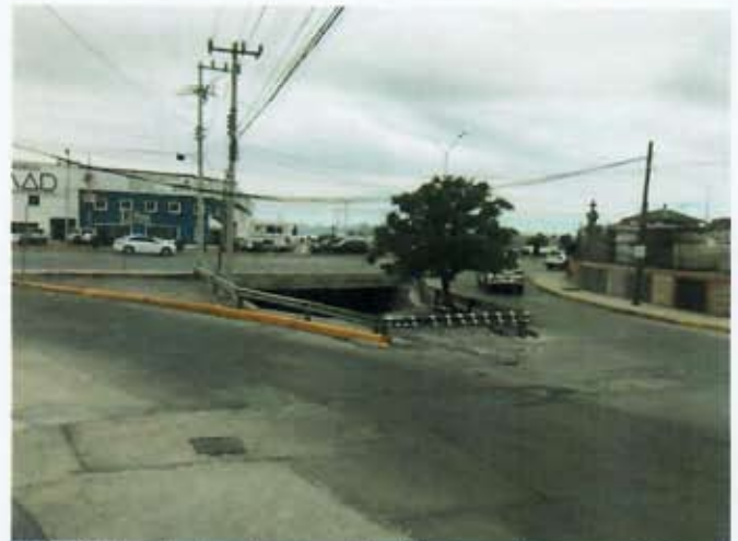
Fig. 70 Infraestructura de cruce en Av. de la Juventud para escurrimiento arroyo El Saucito. 80
