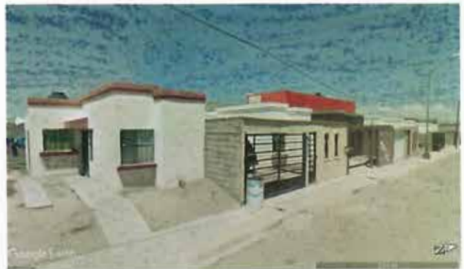
Fig. 37 Tipología de vivienda unifamiliar de interés social en fraccionamientos en la zona. 47
