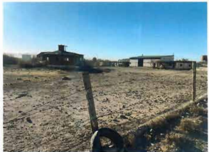
Fig. 8 Vista del Área de Aplicación. 18
