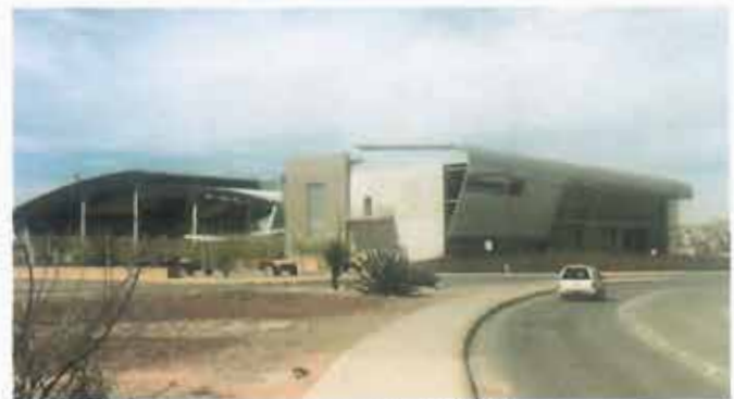
Fig. 70 Terminal Sur del SITP. 80
