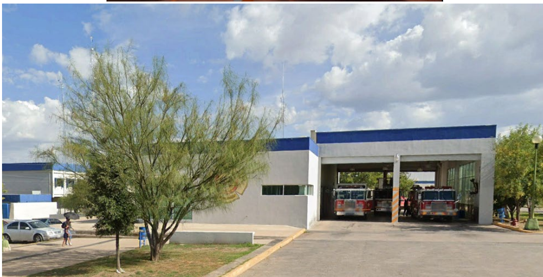
IMAGEN 88.- ESTACION DE BOMBEROS No 3. FUENTE: ELABORACION PROPIA.
