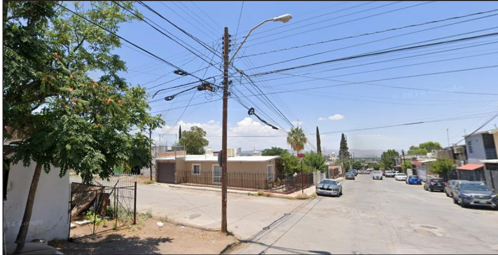
Imagen 64. Vista de infraestructura eléctrica cercana al predio de estudio.
