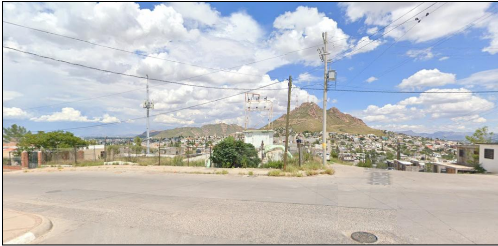
Imagen 53. Infraestructura de energía eléctrica en el Blvd. Juan Pablo II.
