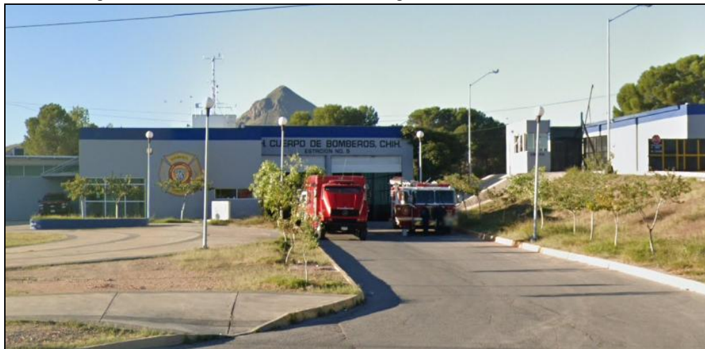
Imagen 34. Unidad de atención de emergencia, Estación de Bomberos.
