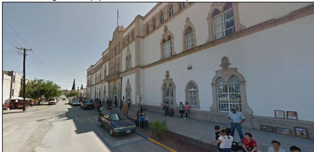
Imagen 32. Equipamiento de salud. Hospital Central Universitario.
