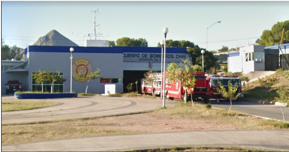
Imagen 59. Unidad de atención de emergencia, Estación de Bomberos.
