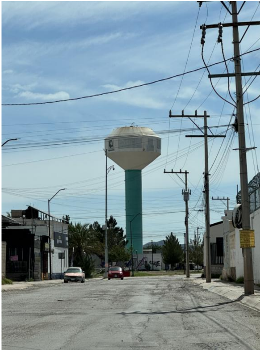
Imagen 2 Tanque elevado de la JMAS en zona industrial-habitacional del suroriente de Chihuahua. Fuente: Fotografía propia tomada en campo (2025). Ubicación aproximada: entorno inmediato al polígono de la Parcela 308, suroriente de Chihuahua, Chih.
