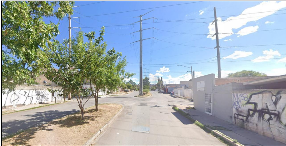
Imagen 47. Infraestructura de energía eléctrica en la Calle Coordinadora.
