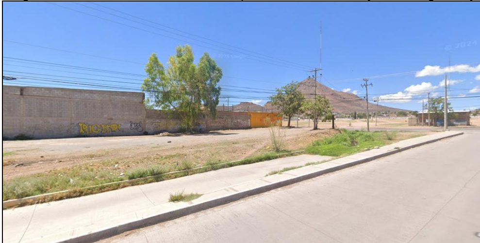
Imagen 8. Canalización de escurrimientos pluviales, hacia el arroyo San Jorge Arroyo
