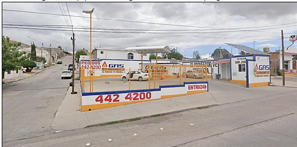
Imagen 31. Equipamiento de gas carburación en el polígono de análisis.
