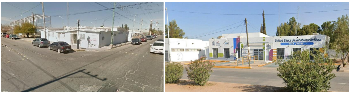
Imagen 60. Centro de Salud División del Norte y Unidad Básica de Rehabilitación Física. Fuente Google Earth 2024.
