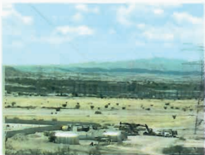
Fig. 63 Subestación eléctrica al surponiente en el Área de Estudio. 73
