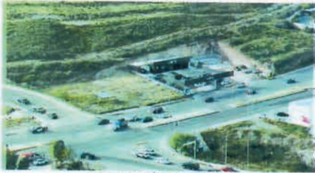
Fig. 5 Vista del Área de Aplicación. 15
