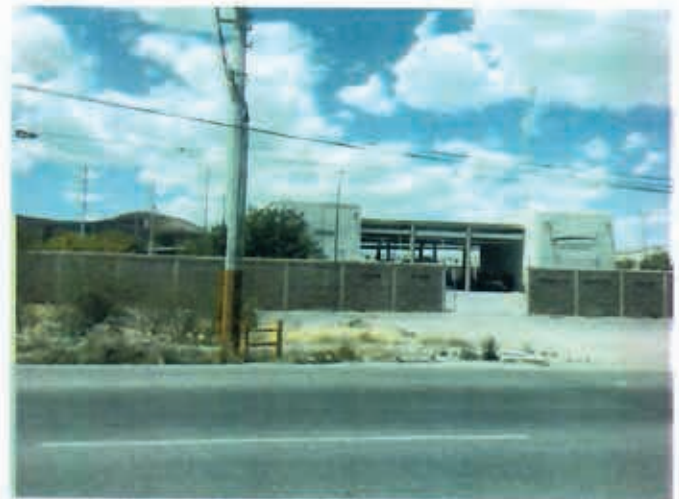
Fig. 43 Estación Dual No 7. 53
