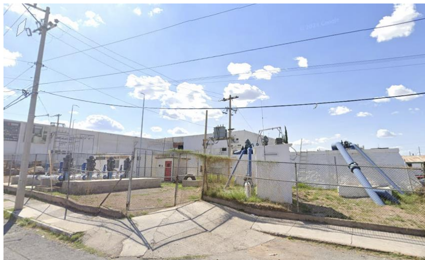
Figura 83 – Tanque ubicado en calle Pimentel.
