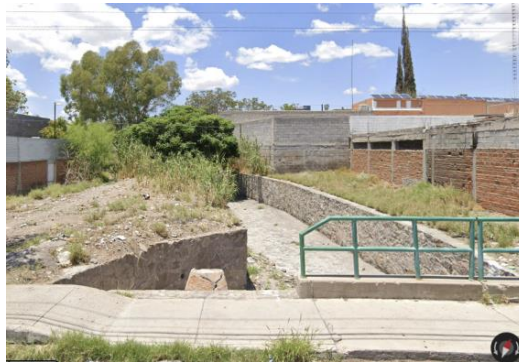
Figura 93 – Arroyo Canalizado "La Galera Norte"
