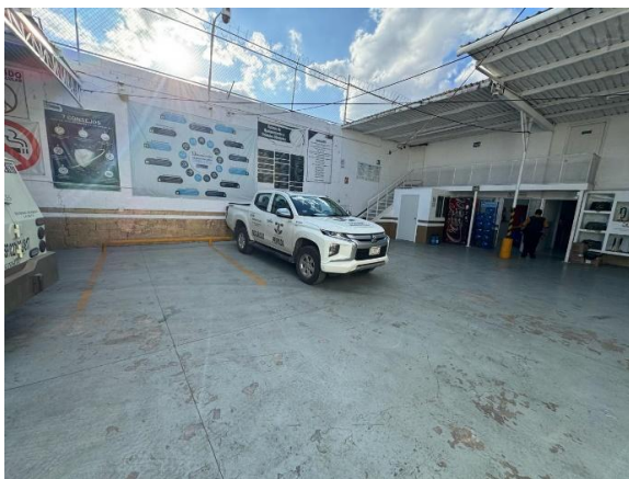
Figura 15 – Fotografías del interior del predio
