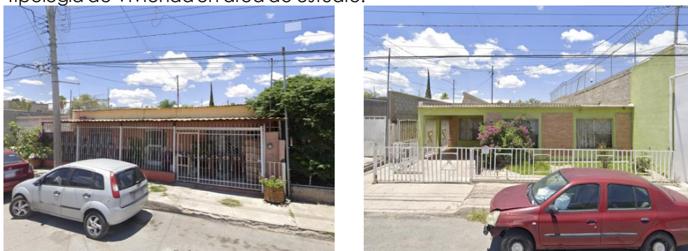
Figura 47 – Viviendas en abandono, ubicadas en C. Ciprés.
