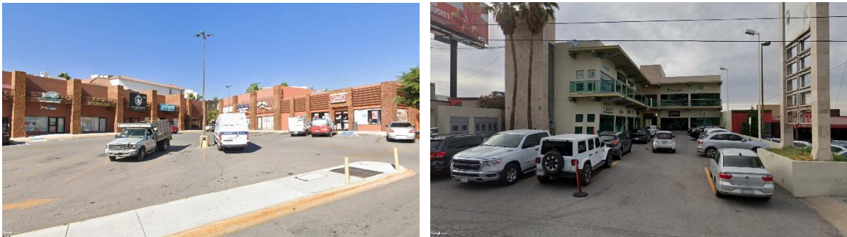
Imagen 48. Plaza comercial sobre Av. Tomas Valles Vivar y Plaza Cantera sobre Av. Mirador. Fuente: Captura Google Earth, abril 2025.
