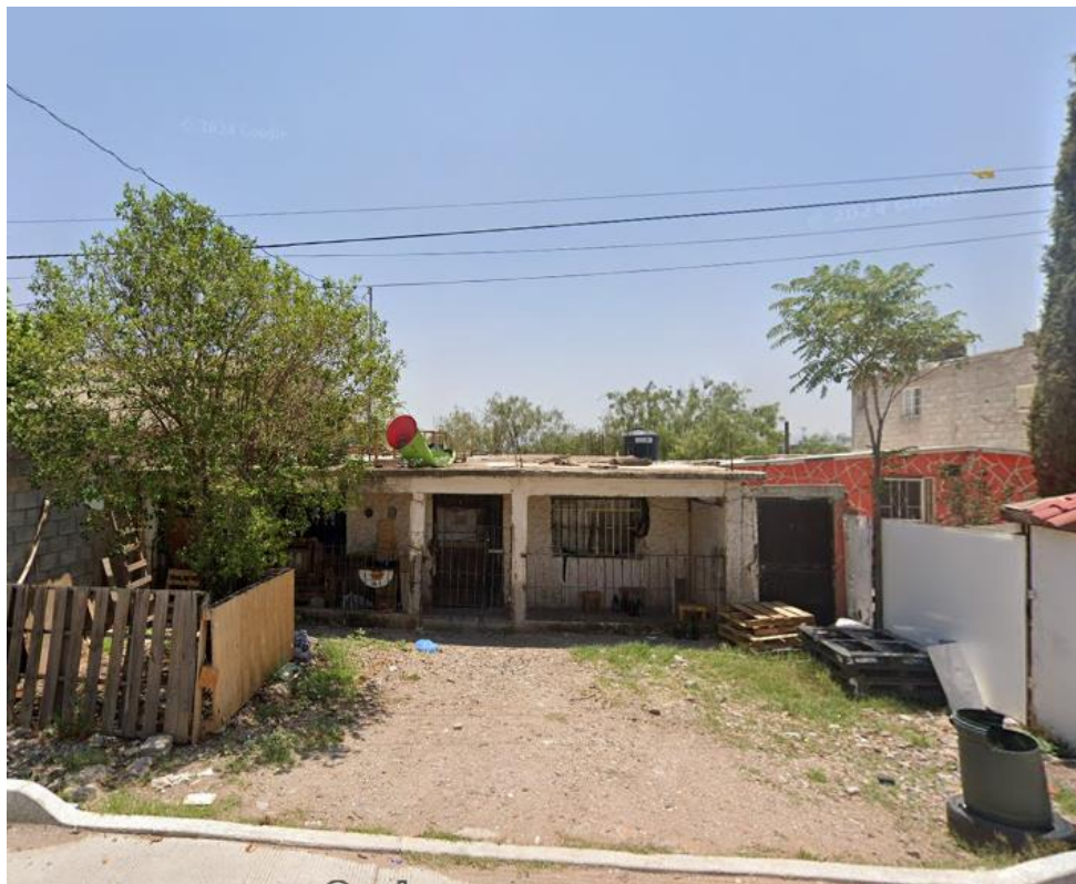
Figura 47 – Viviendas en abandono, ubicadas en área de estudio
