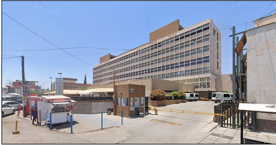
Imagen 36. Equipamiento salud, Hospital “José María Morelos, IMSS”.
