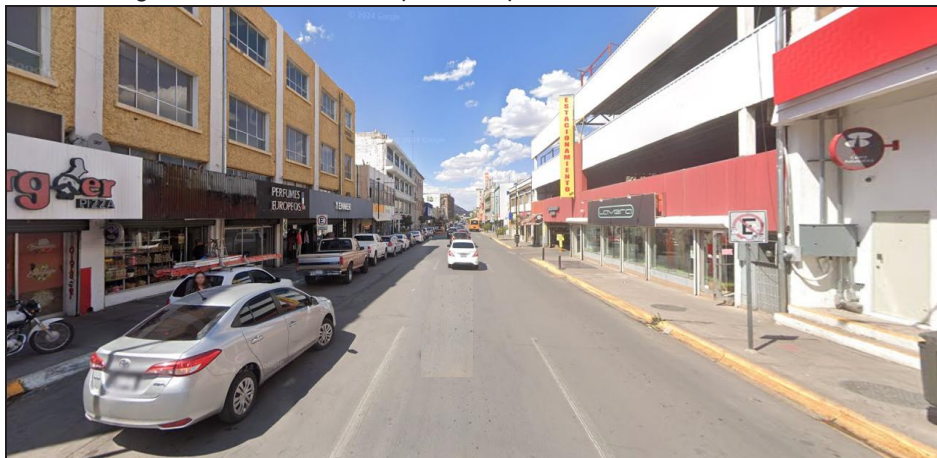
Imagen 69. Escurrimientos pluviales por Av. Juan Aldama González.
