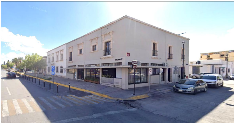
Imagen 22. Usos de giro comercial y servicios con vivienda en el polígono de estudio.
