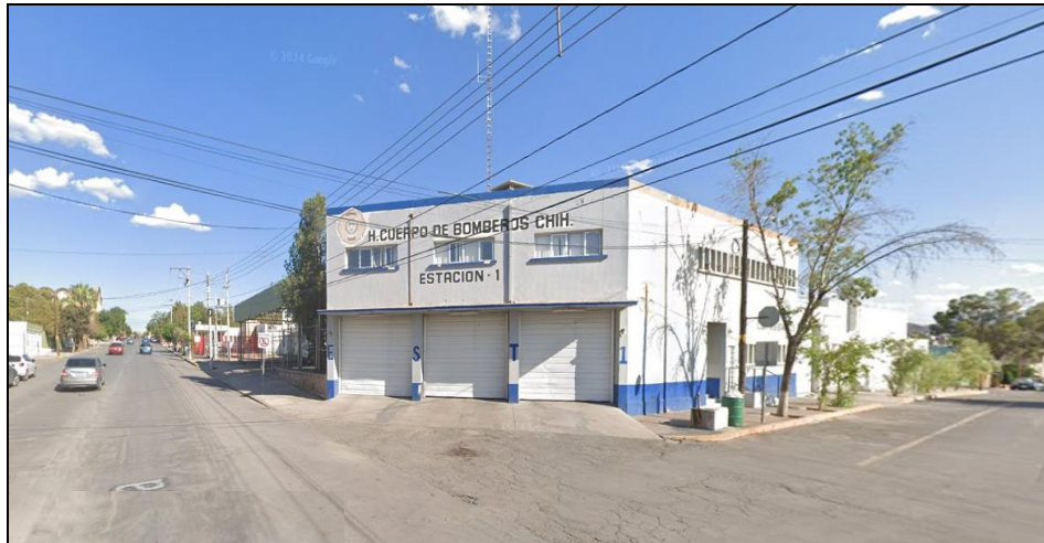
Imagen 43. Equipamiento de servicios. Estación de Bomberos No. 1
