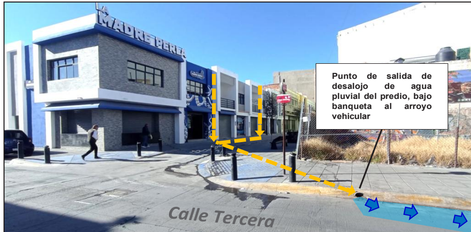
Imagen 67. Esquema de desalojo de agua pluvial del predio a la calle José María Morelos.
