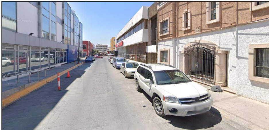
Imagen 68. Escurrimientos pluviales por calle Tercera.
