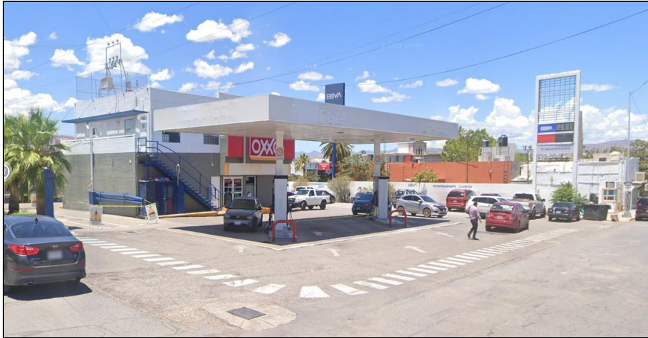
Imagen 42. Equipamiento de servicios. Gasolinera en calle 12
