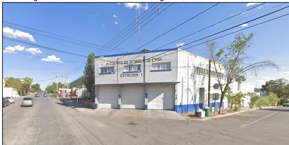
Imagen 76. Unidad de atención de emergencia, Estación de Bomberos 1.
