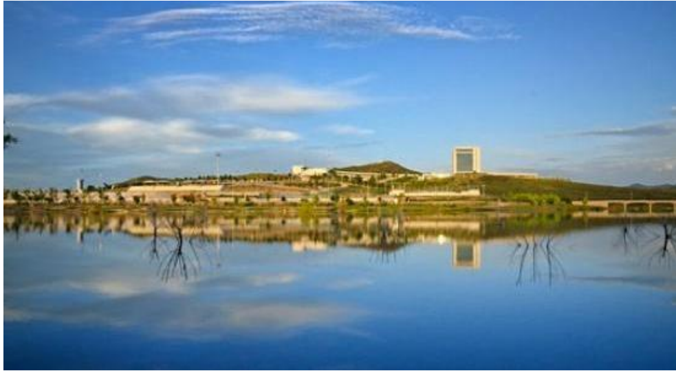
Presa El Rejón y al fondo los edificios de la Universidad La Salle, ULSA
