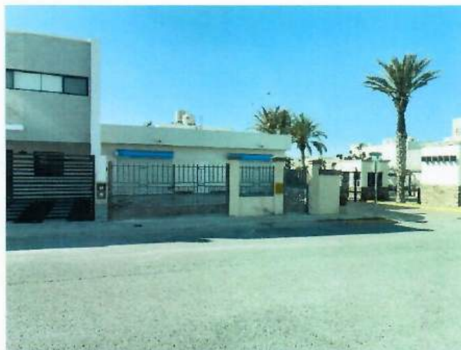
Fig. 2 Vista del Área de Aplicación. 12
