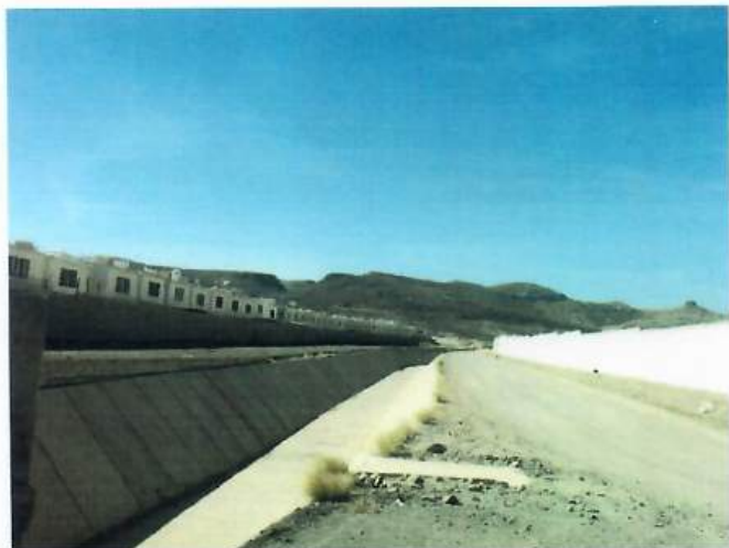
Fig. 53 Canal arroyo Los Arcos. 63
