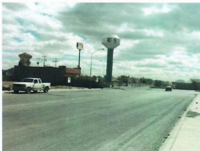
Fig. 52 Tanque de almacenamiento Quinta Montecarlo. 62
