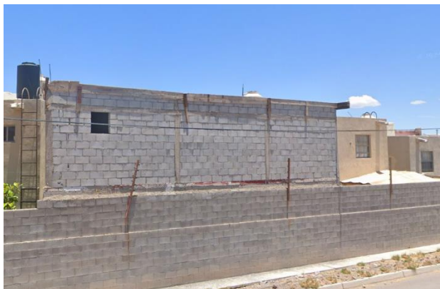
Figura 39 – Vivienda en construcción, ubicadas en Av. Mariano Valenzuela. Fuente: Propia.
