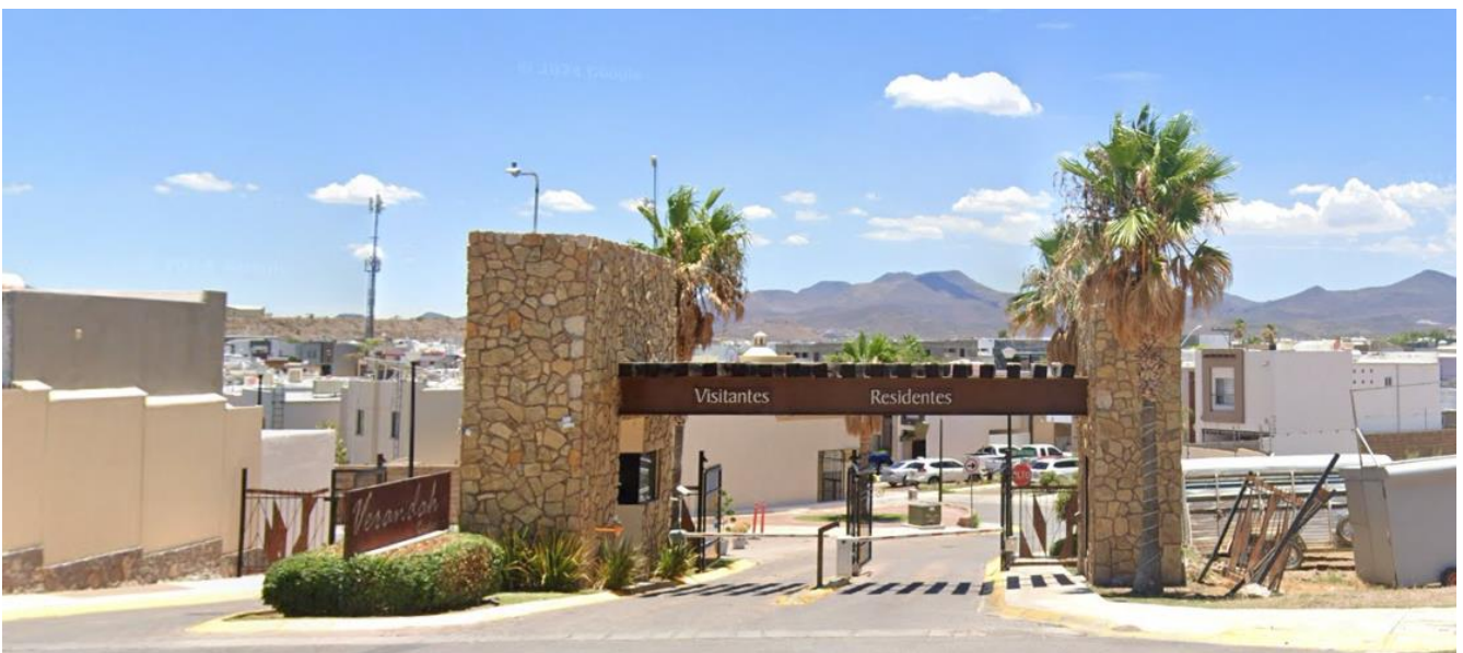
Figura 28 – Residencial Vesandah, ubicados en Av. Pedro Zuloaga. Fuente: Propia.
