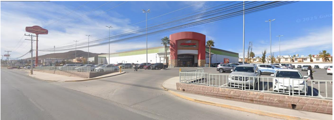
Figura 17 - Supermercado "Alsuper", ubicados en Av. Teófilo Borunda. Fuente: Propia.
