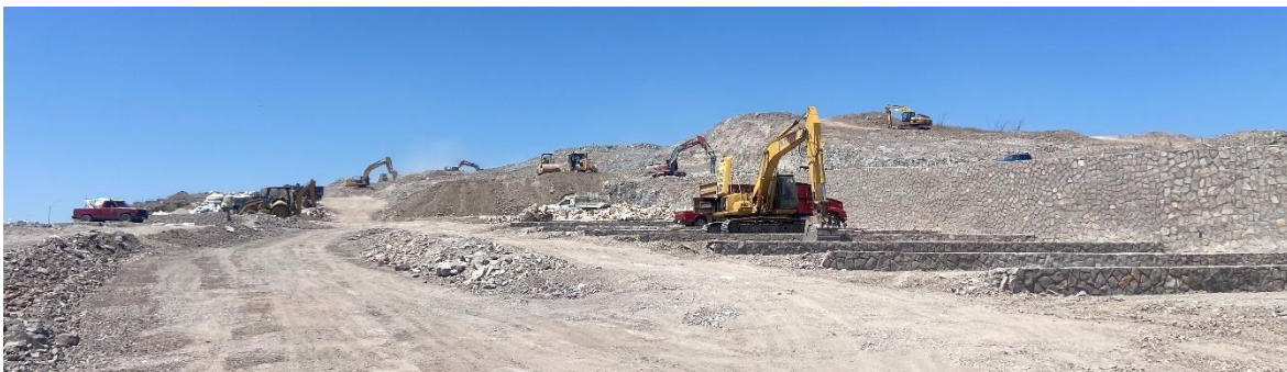
Ilustración 22. Terracerías de predio en estudio. Fuente: Propia TDU 2025.
