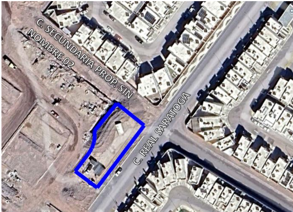
Ilustración 4. Lote de 983.629 m2 en estudio. Fuente: Google Earth.
